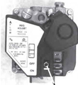
氣體控制閥「ON/OFF（開/關）」切換器
