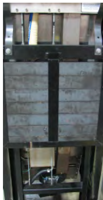
拆下蓋板後的配重裝置視圖
