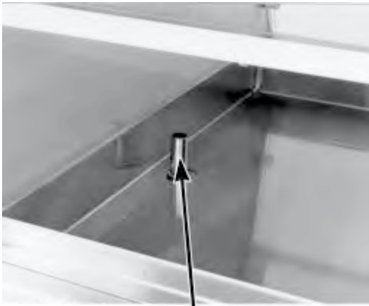
ΚΑΤΑΚΟΡΥΦΟΣ ΥΔΡΟΣΩΛΗΝΑΣ ΑΠΟΧΕΤΕΥΣΗΣ
