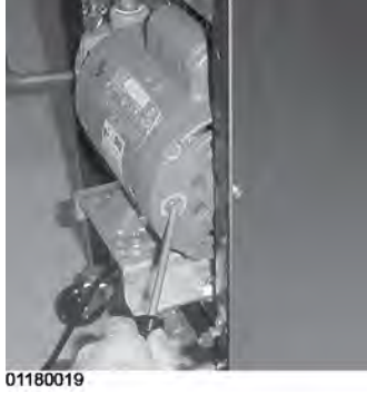
Şekil 3-10 Filtre Pompa Motoru Koruma Cihazının Manuel Reseti
